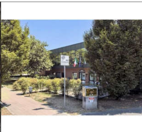
Vista d'insieme dell'immobile
