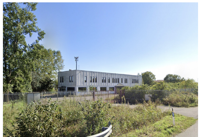
Viste dell'area di intervento
