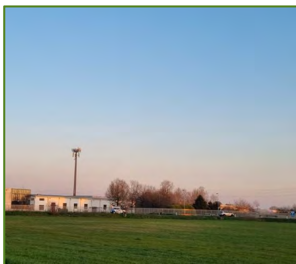
Dopo i lavori di interrimento della linea
