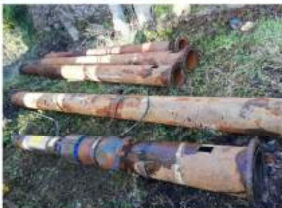
Foto 14 - Rimozione pompa Pozzo 1
