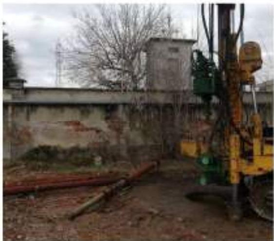
Foto 16 - Rimozione pompa Pozzo 8
