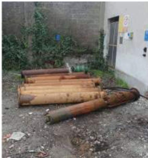
Foto 15 - Rimozione pompa Pozzo 6
