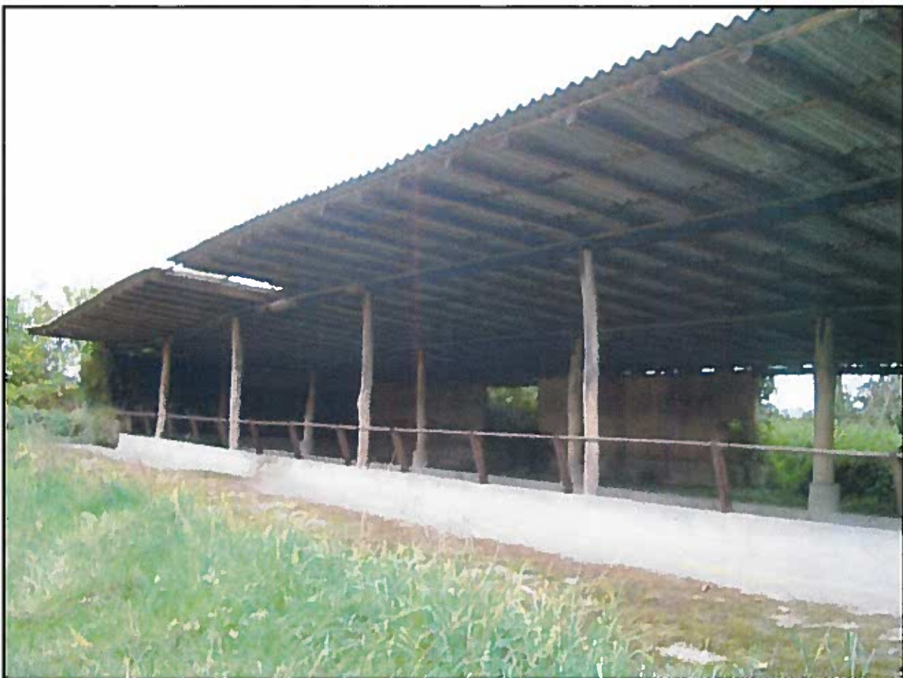
Foto 2 = EDIFICIO "p" ( Stalla aperta )
